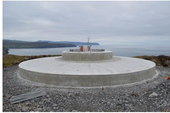
Mynd 4 – Stoypt fundament
