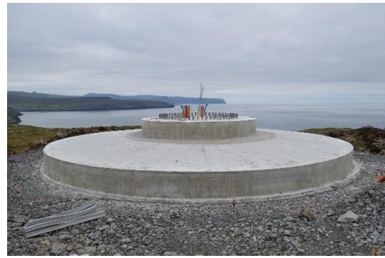
Mynd 4 – Stoypt fundament
