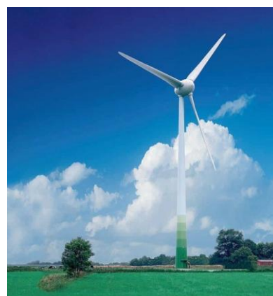
Mynd 7 ENERCON E-44
