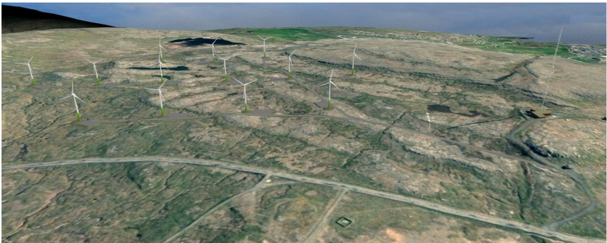
Mynd 1 Vindmyllur í Húsahaga
