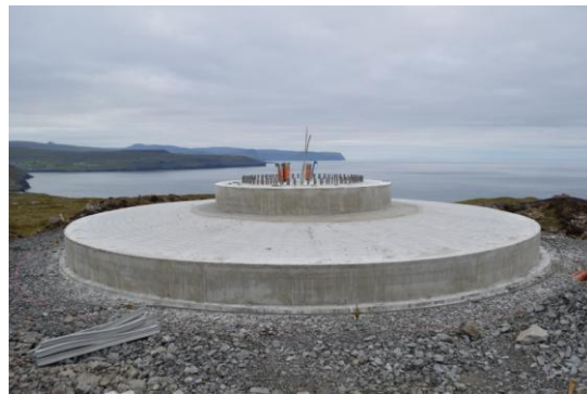
Mynd 11 Stoypt fundament
