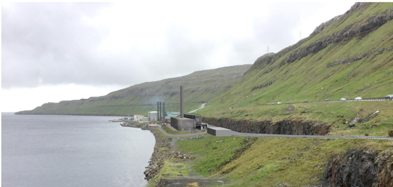
Mynd 30 vísir verkið sæð frá landsvegnum vestanfyri.
