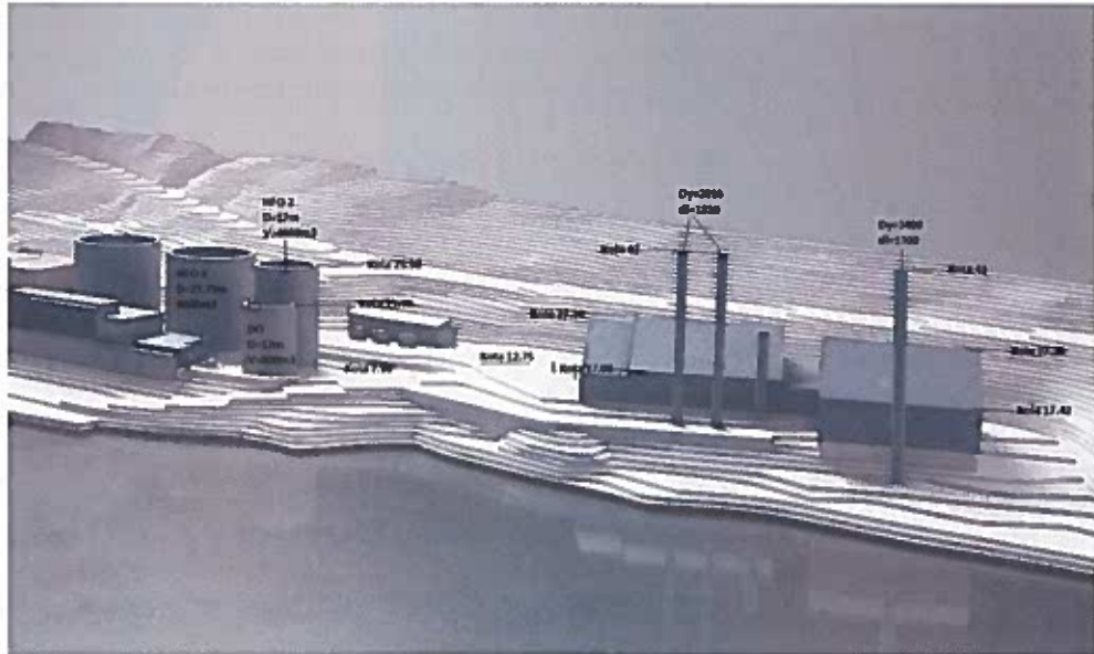
Figur 2.1. Tegning af de eksisterende skorstene – de to lige høje skorstene er M1 og M2, mens skorstenen yderst til højre er M_45. Der planlægges en ny bygning med skorstenen M_6789 til højre for de viste bygninger.
