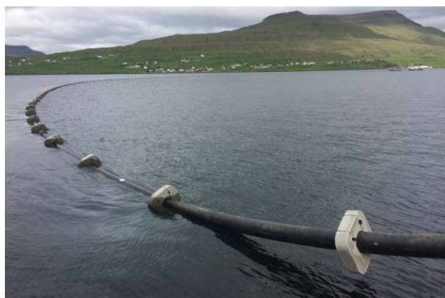
Mynd 4.1: Vatnleiðing tvørtur um Skálafjørðin. Ein slamleiðing líkist nógv vatnleiðingini.
